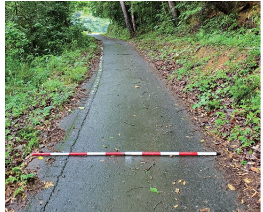
写真1 既設道の幅員確認
